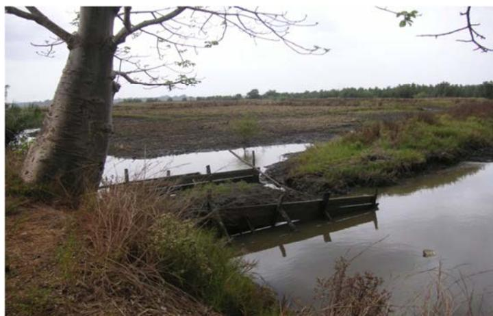
**Figure 34. Digue de ceinture réalisée dans le cadre du projet riz Basse-Guinée et endommagée lors de l'enneigement des plaines estuariennes (photo : auteur)**
