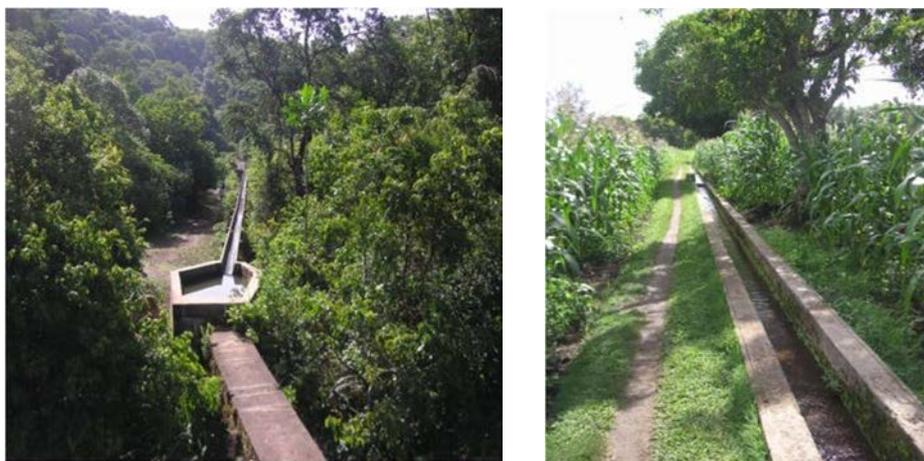
Figure 7. Aménagements hydrauliques des périmètres irrigués : canal de dérivation du cours d'eau en amont (à gauche) et canal d'irrigation gravitaire au sein du périmètre aménagé (à droite) (photos : auteur)
