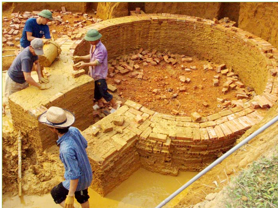
Construction d'un four en brique. Patrice Lamballe, Gret.
