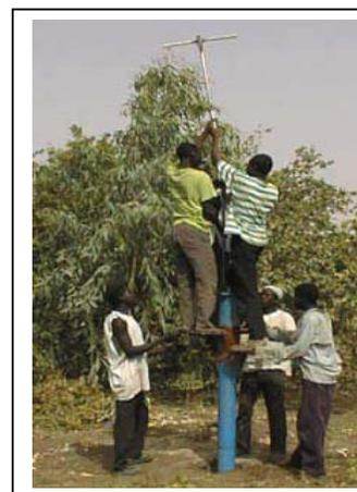
**Utilisation recommandée :** Le forage manuel est recommandé pour l'irrigation dans les zones où le sol qui est au niveau de la nappe ne contient pas des quantités importante d'argile ou de limon. Sa performance est supérieure dans les zones ou l'aquifère se trouve dans un sable grossier de plus de trois mètres d'épaisseur.
