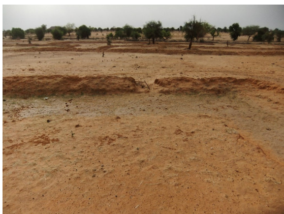
Banquettes récemment installées (1 an) sur un plateau dégradé dans la commune de Torodi. La digue a cédé à cause de la pente trop forte pour ce type d'ouvrage (programme PAC).
