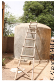
un impluvium hors sol en Ferrociment de 15 m 3 à Natiaboani
