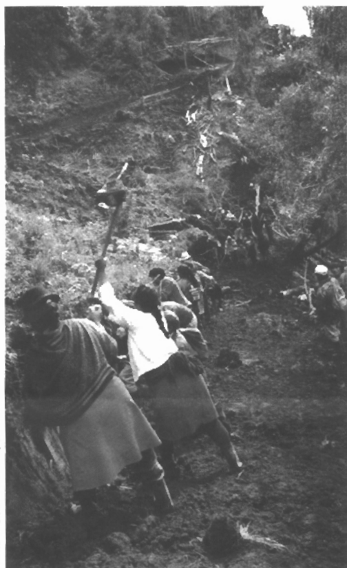
Tous ceux qui veulent de l'eau doivent travailler : lors des préparatifs pour la nouvelle conduite d'eau, toutes les aides sont requises.
