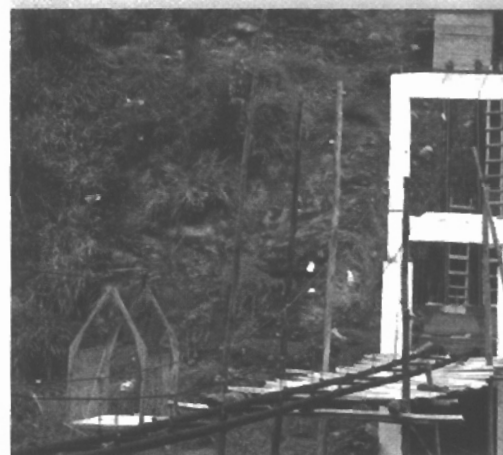
L'ingéniosité au service de la communauté : un pont impressionnant permet d'acheminer l'eau potable au-dessus du fleuve.
