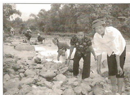
Réparation d'une route en commun.
