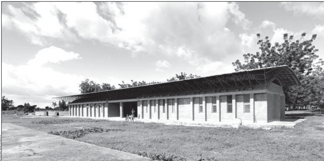
L'école de Gando, au Burkina Faso. Elle possède une enveloppe en briques rouges de terre crue, avec des éléments de béton armé; la ventilation des locaux est garantie par d'amples fenêtres colorées munies de fentes d'aération. Une seconde couverture métallique très étendue fournit de l'ombre. ARCHIVES
